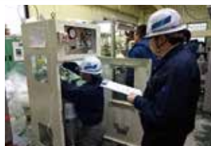
排ガス処理筒交換実技指導
